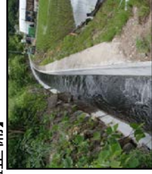
老朽化した用水路の整備・更新
