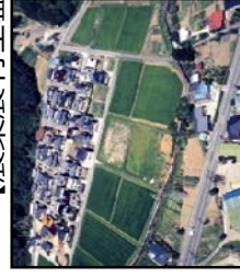
ほ場整備による農業生産性の向上と秩苜ある土地利用の推進
